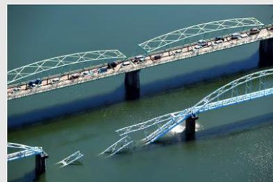
床版や横桁などの二次部材は橋梁の部材損傷後の余耐力(冗長性)に大きく寄与している
