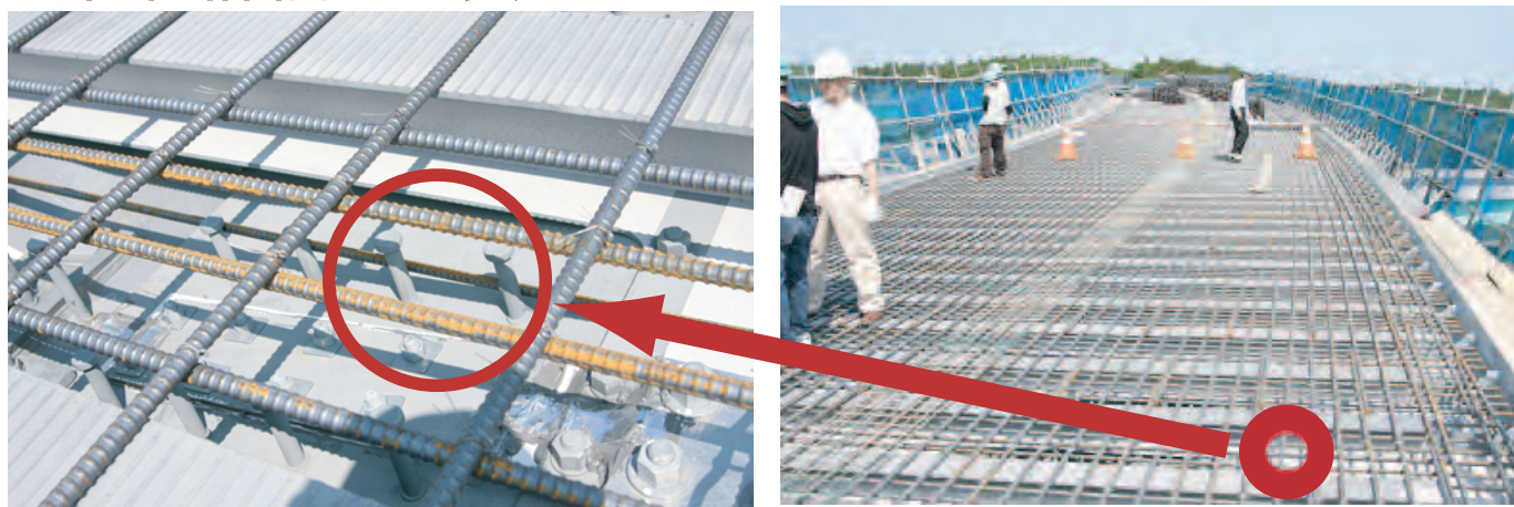
ずれ止め << 床版全体 (コンクリート打設前)
