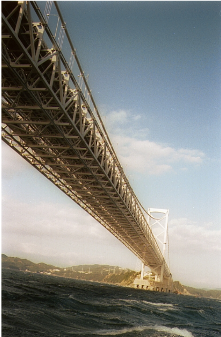
大鳴門橋 1985年竣工
