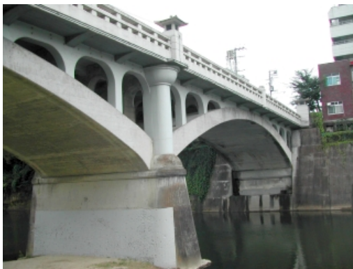
(a) 御霊屋橋 (仙台の広瀬川)
