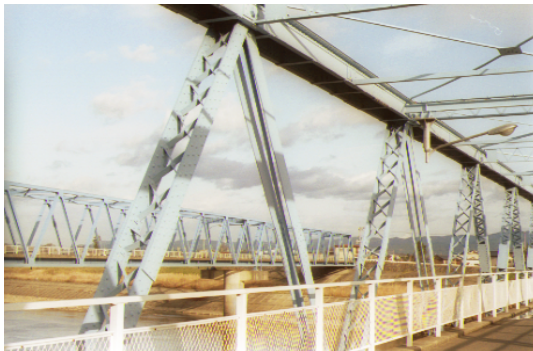
(a) 元は鉄道橋、今は歩道橋
